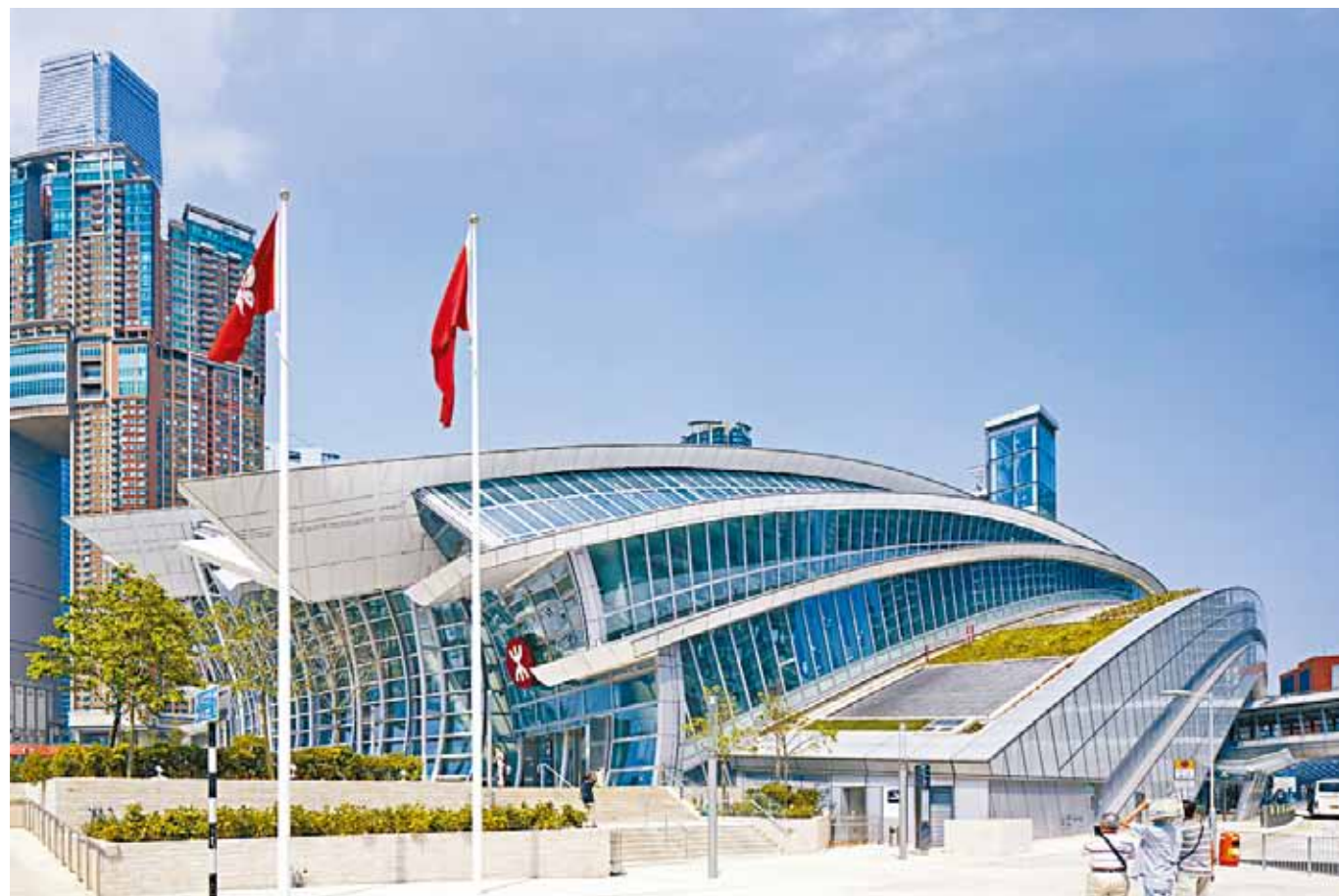
■香港西九龍站的消防工程榮獲「消防工程卓越大獎」
