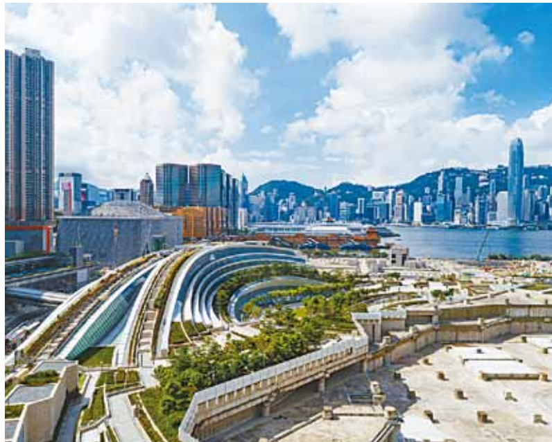
■香港西九龍站靜態排煙口無縫結合綠化屋頂實現持續發展理念。
