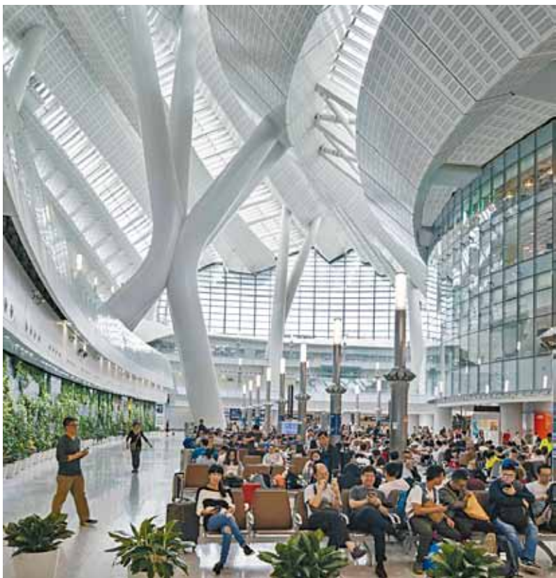
■高速鐵路站中庭由獨特的鋼結構支撐，並具有適當的防火功能。
